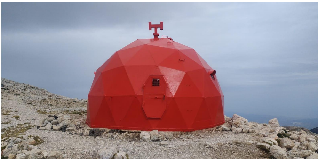
Stato del Bivacco al termine dell'intervento di manutenzione
